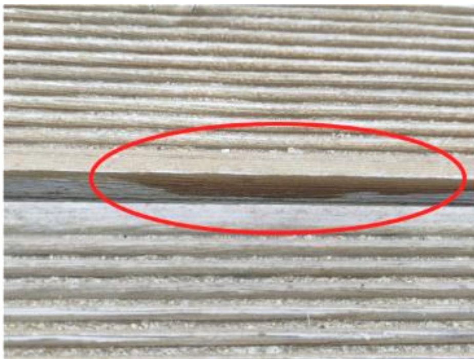
Рис. 9. Потёки льняного масла на боковой поверхности террасных досок
