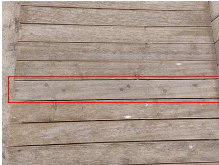
Рис. 6. Сучки на поверхности досок
