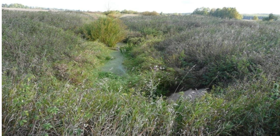
Рисунок 1. Заросший водоотводной канал, пойма р. Кудьма
